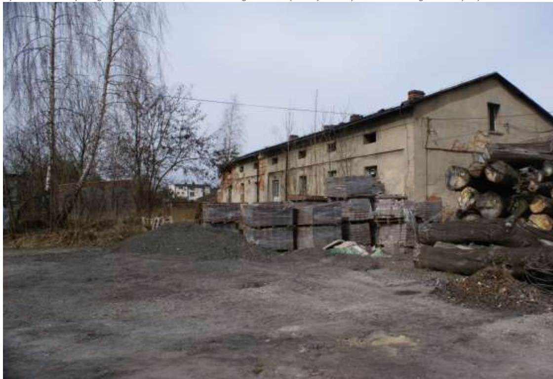
Rysunek 28 Budynki gospodarcze na terenie dawnego dworu (nieczynna wytwórnia wód gazowanych)
