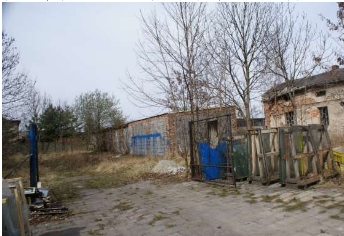
Rysunek 29 Budynki gospodarcze na terenie dawnego dworu (nieczynna wytwórnia wód gazowanych)
