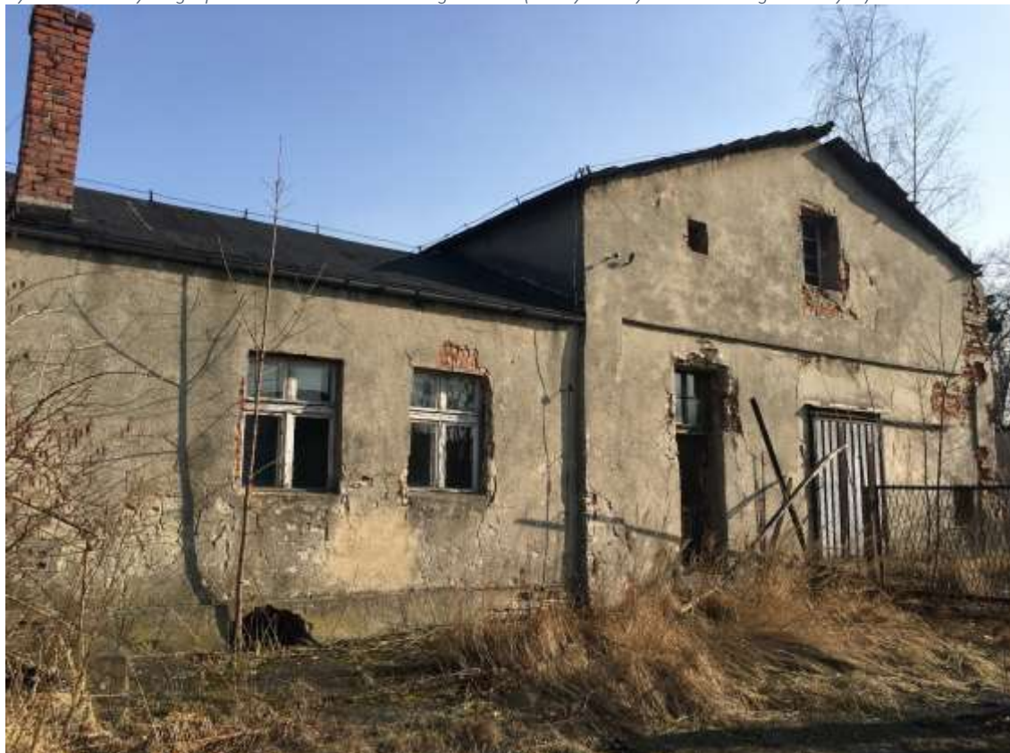
Rysunek 32 Budynki gospodarcze na terenie dawnego dworu (nieczynna wytwórnia wód gazowanych)
