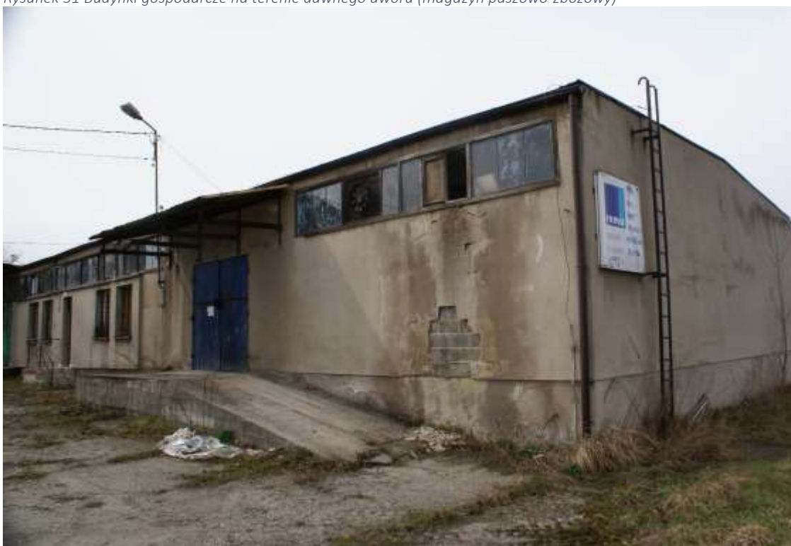
Rysunek 31 Budynki gospodarcze na terenie dawnego dworu (magazyn paszowo-zbożowy)
