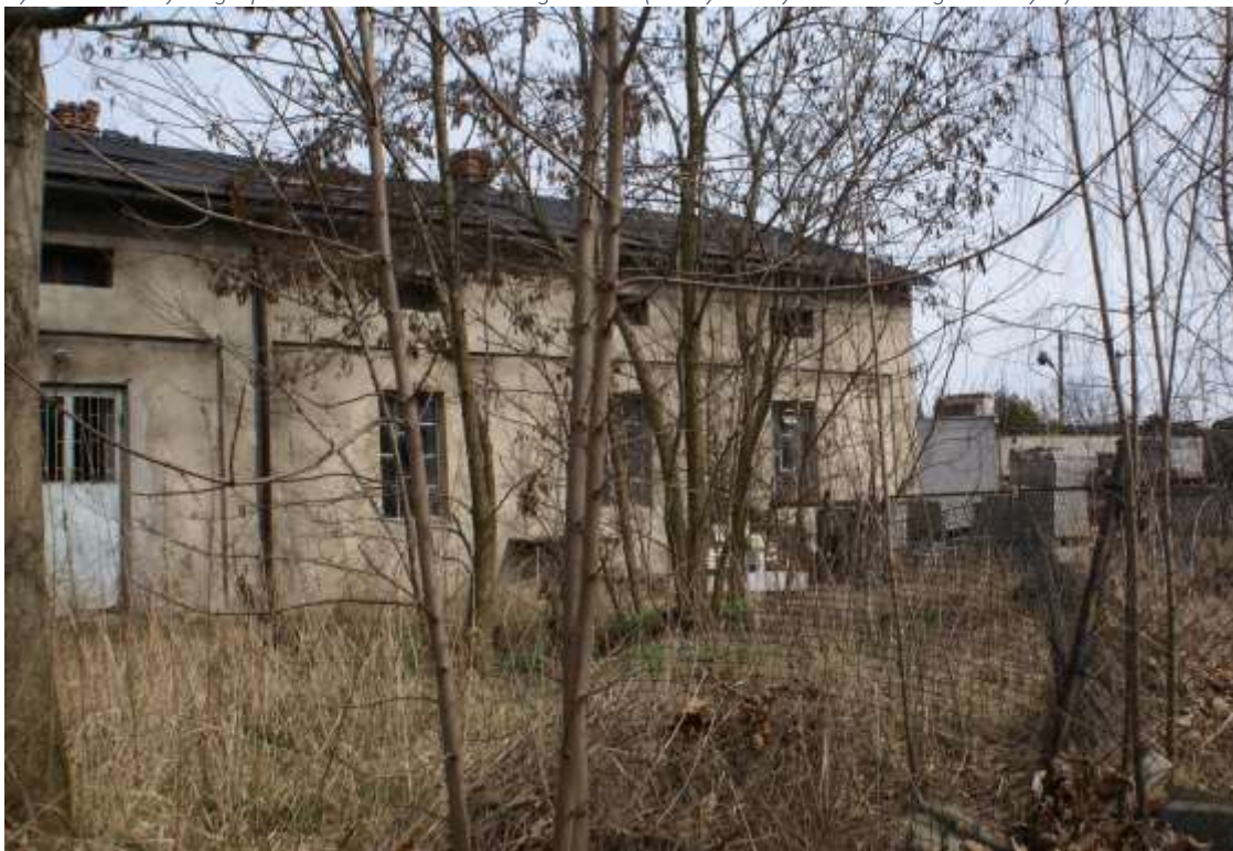
Rysunek 30 Budynki gospodarcze na terenie dawnego dworu (nieczynna wytwórnia wód gazowanych)
